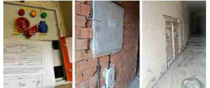
Asansör Tescil Belgesi, Mekanik ve Elektrik Tesisatı Kontrolleri Örnek Fotoğrafları
