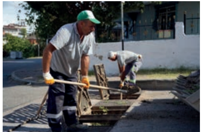
Yağmur Suyu Izgarası Temizliği
