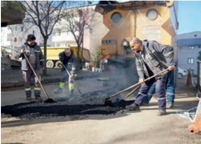
Asfalt Yama Çalışması
