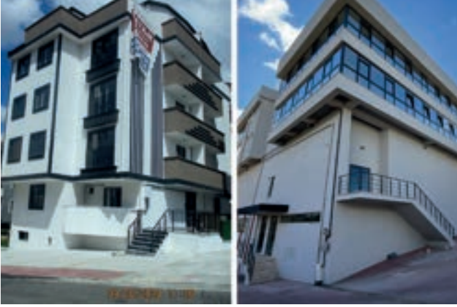
(Yapı Kullanma İzin Belgesi Aşamasındaki Yapılar Örnek Fotoğrafları)
