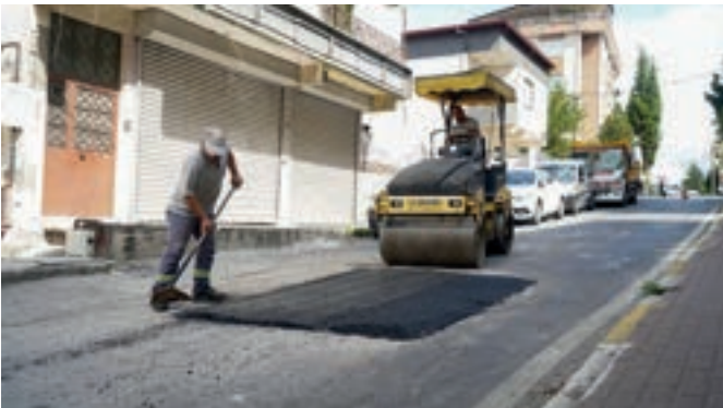
Asfalt Yama Çalışması
