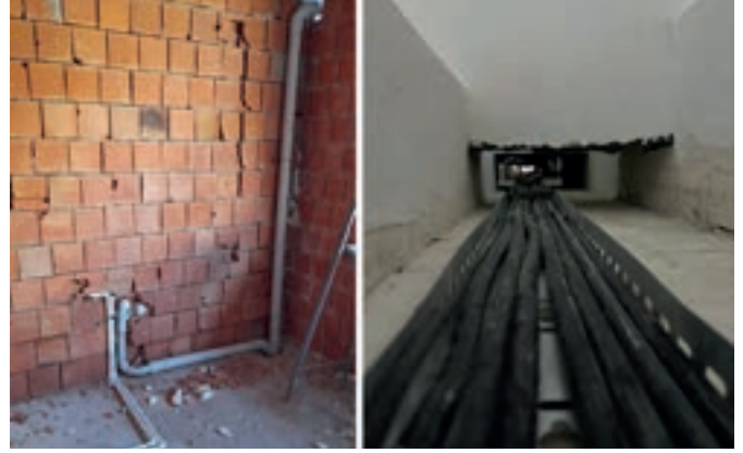
(Mekanik ve Elektrik Tesisatı Kontrolleri Örnek Fotoğrafları)
