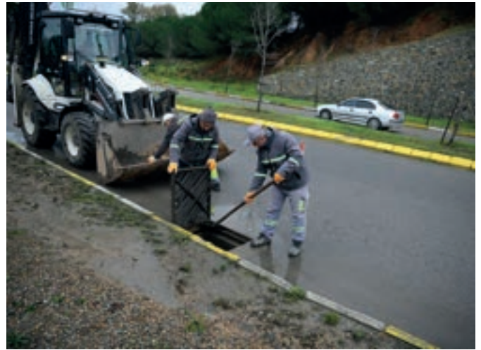
Yağmur Suyu Izgarası Temizliği
