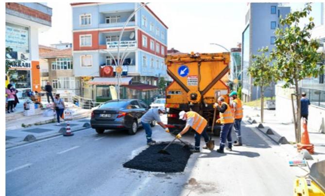
Asfalt Yama Çalışması
