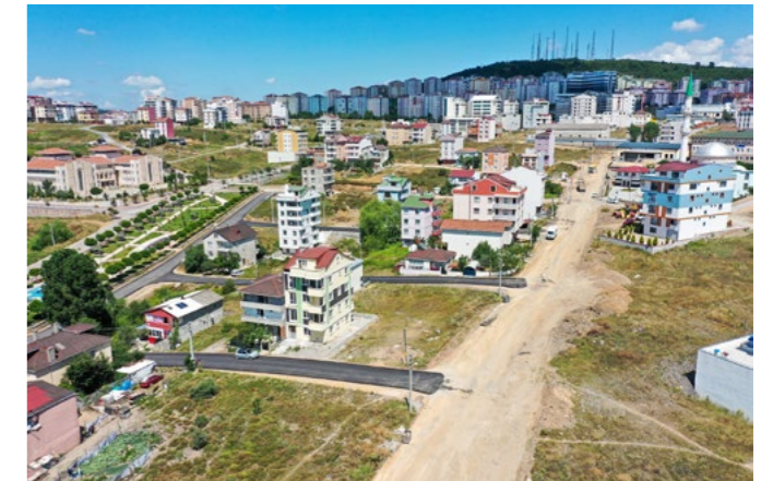
Emek Mahallesi Asfaltlama Çalışması
