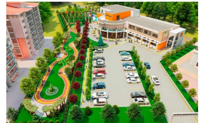
Engelliler Merkezi Genel Görünüşü
