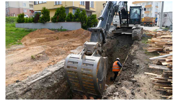
Yağmur Suyu Hattı Çalışması
