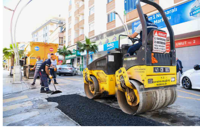
Asfalt Yama Çalışması
