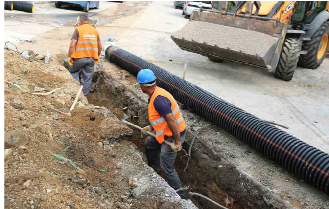
Yağmur Suyu Hattı Çalışması
