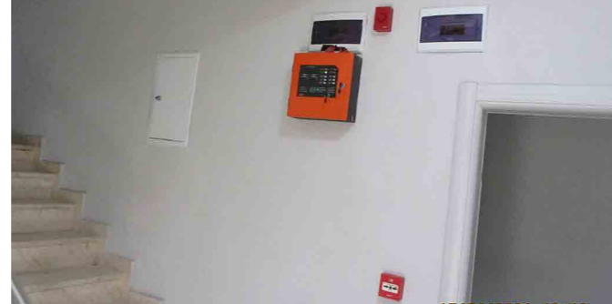
(Mekanik ve Elektrik Tesisat Kontrolleri)
