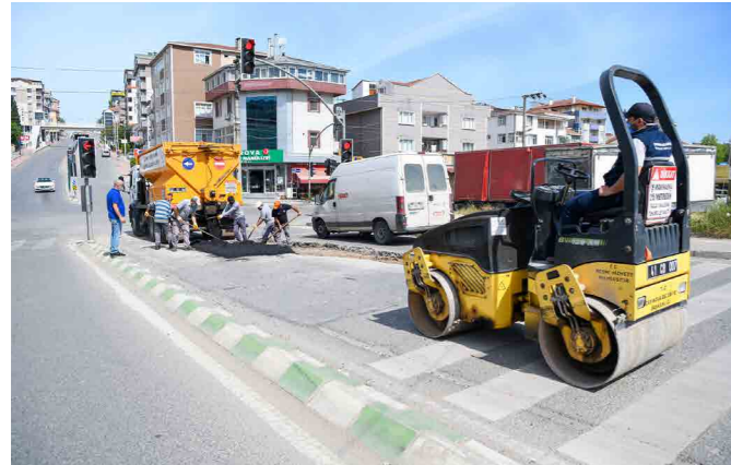
Asfalt Yama Çalışması
